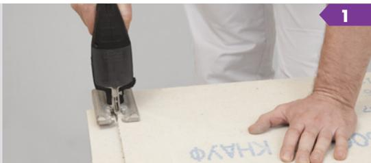
Рекомендуется начинать укладку элементов пола от стены с дверным проемом справа налево. Обрезанная сторона элемента должна быть обращена к стене, а выступающий фальц противоположной стороны внутрь помещения (рис. 1).
