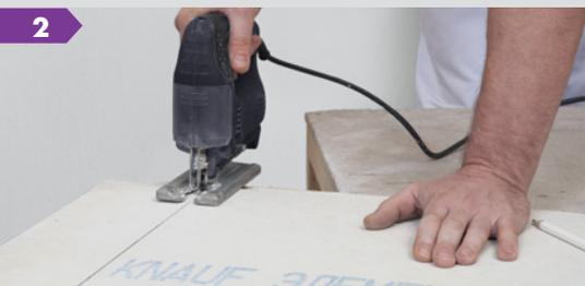
При помощи электроинструмента (например, электролобзика) разрезать ЭП по намеченной линии.
