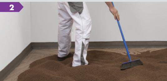
Распределить сухую засыпку слоем, близким к проектной толщине, учитывая, что минимально допустимый слой составляет 20 мм.
