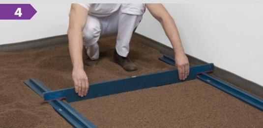
Провести нивелирование сухой засыпки при помощи комплекта реек.
