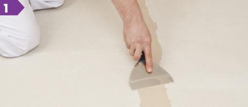
При укладке финишных покрытий с повышенными требованиями к основанию (например, гомогенного линолеума) рекомендуется провести заделку стыков и мест установки шурупов шпаклевочными составами КНАУФ-Фуген ГВ или КНАУФ-Унифлот.
