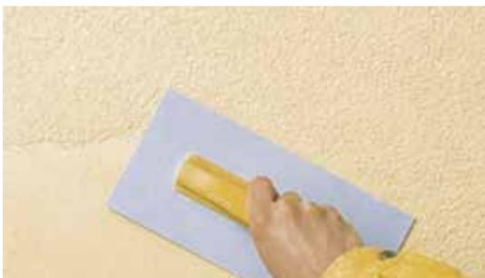
После нанесения штукатурки, в момент ее начального схватывания, когда масса не прилипает к инструменту, необходимо придать однородную фактуру при помощи пластмассовой терки. При этом терку следует держать параллельно обрабатываемой поверхности, слегка прижимая к ней (рис. 39). Не допускается опрыскивать штукатурку водой.
