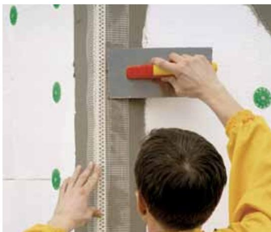
Во всех местах примыкания армирующей стеклосетки к строительным деталям или проемам, например, к оконным рамам, трубным вводам необходим чистый срез материала для предотвращения отрыва в этом месте.
