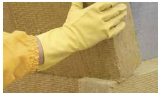
Запрещается выравнивание стыков плит клеем. Открытые швы следует заделать кусочками клиньями из материала утеплителя на всю глубину или монтажной пеной Ceresit TS (рис. 17).
