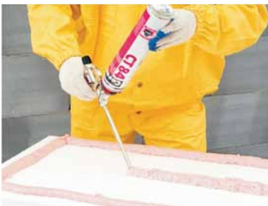
При наклеивании теплоизоляционных плит их располагают длинной стороной по горизонтали, впритык друг к другу с вертикальной перевязкой стыков не менее 100 мм. Приклеивание плит производится в направлении снизу вверх. Перед наклеиванием плиту утеплителя размещают на стене насухо, чтобы выявить степень примыкания граней соседних плит. В случае несовпадения граней выполняют подгонку плит друг к другу, стачивая грани деревянным бруском, обернутым наждачной бумагой.
