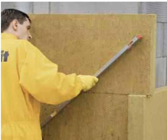
В случае неправильно приклеенной теплоизоляционной плиты следует ее оторвать, снять клеящую смесь со стены и плиты, после чего другой раз наложить клеящую смесь на плиту и прижать ее к поверхности стены. Система расположения плит на поверхности стены и угла показана на рисунке 20а, а около проемов - на рисунке 20б. На стенах из сборных элементов теплоизоляционные плиты следует разместить так, чтобы их стыки не совпадали с соединениями стен.
