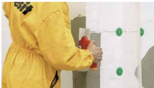
Толщина клеящего слоя при одинарной стеклосетке должна составлять не менее 3 мм и не более 5 мм. Недопустимо приклеивание стеклосетки, накладывая ее на теплоизоляционную плиту, не покрытую клеящим составом, которую затем наносят один раз на стеклосетку.
