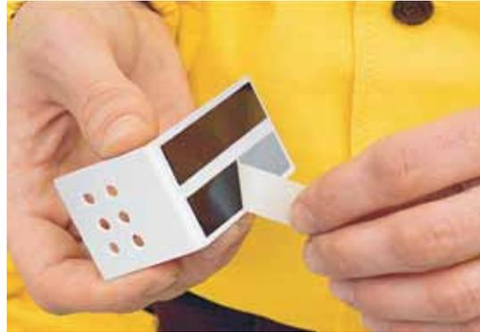
Уголок следует прижать к основанию так, чтобы меньшая часть уголка прилегала к фронтальной стороне плиты утеплителя. После установки плиты в вертикальном и горизонтальном положении, штырь следует вставить в отверстие уголка, чтобы надежно ее зафиксировать. Следующую плиту необходимо насадить на выступающий штырь, так чтобы ее грань была на одном уровне с гранью ранее установленной плиты утеплителя (рис. 23).
