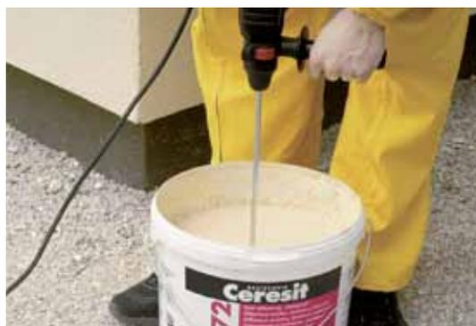
Нанесение декоративно-защитного слоя производится согласно инструкции. При устройстве декоративно-защитного слоя для создания однородной поверхности фасад следует разбивать на вертикальные и горизонтальные захватки таким образом, чтобы избежать стыков на сплошных участках. Границы захваток должны определяться с учетом архитектурных особенностей фасада.
