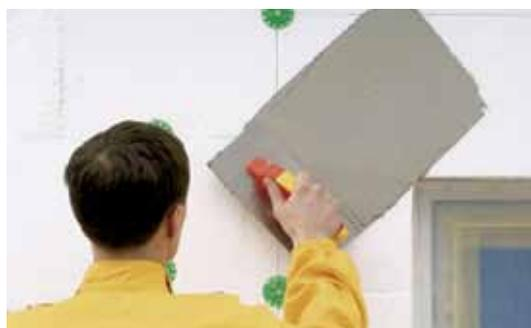
В переходной области между верхним и боковым откосами необходимо также уложить дополнительную полосу стеклосетки, чтобы обеспечить необходимое перекрытие армирования угла. Стеклосетку всегда укладывают до установки угловых защитных накладок. Период между этими процессами должен быть минимальным. На нижнем краю армирующая стеклосетка должна запускаться на отбортовку стартового профиля.
