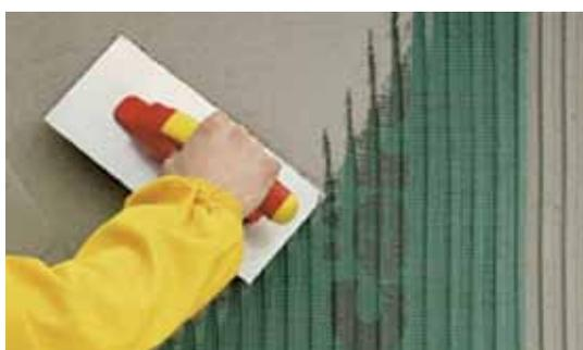
В цокольной части и в части первого этажа утепленных стен следует применять два слоя стеклосетки. Если стены здания подвержены механическим воздействиям, тогда двойной слой сетки должен быть установлен по всей высоте стен первого этажа. В случае, когда доступ к зданию затруднен, достаточно установить два слоя стеклосетки до высоты около 2,5 м от уровня отливки.
