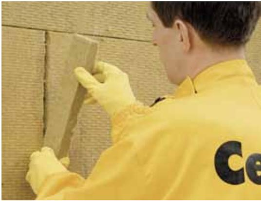
Если клеящая смесь выйдет за контур плиты, необходимо ее удалить (рис. 18). Не допускается повторное прижимание приклеенных теплоизоляционных плит и перемещение плит после истечения нескольких минут.
