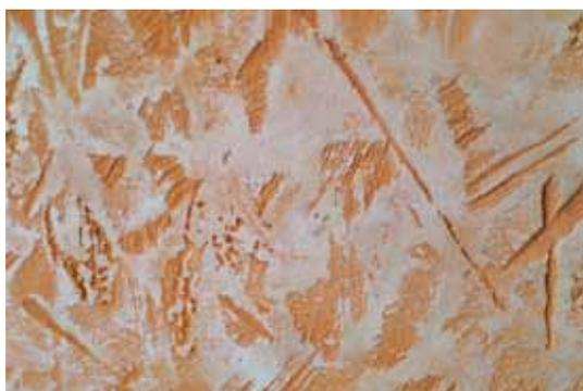
Минеральная штукатурка **Ceresit CT 36**, инструмент нанесения: стальная терка, инструмент фактурирования: венецианский шпатель, шпатель.
