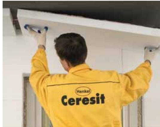
Выступающие неровности поверхности или несовпадения плоскостей соседних плит выравнивают шлифованием терками, обернутыми наждачной бумагой. Падающую при выравнивании плит пыль следует тщательно удалить щеткой с поверхности приклеенных плит (рис. 25).
