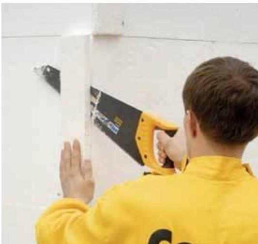
При приклеивании пенополистирольных плит на полиуретановый клей Ceresit СТ 84 Express прибегают к применению дополнительных элементов крепления.
