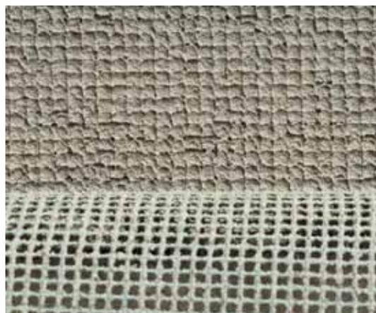
Ширина стеклосетки должна быть подобрана таким образом, чтобы было возможно оклеивание оконных и дверных откосов на всю их глубину.
