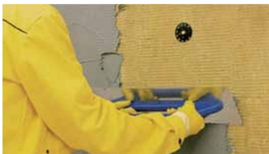
Смежные полосы стеклосетки должны укладываться внахлест, не меньше чем 100 мм по вертикали и по горизонтали, согласно рисунку 34.
