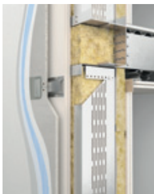
Наружная несущая стена — здание из ЛСТК
