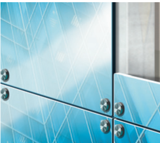
Облицовка панелями из стекла
